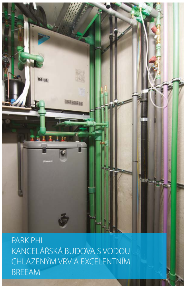
EIFFAGE ENERGIE ET EIFFAGE ENERGIE THERMIE KANCELÁŘSKÁ BUDOVA TEPELNÉ ČERPADLO VRV IV S NEPŘETRŽITÝM VYTÁPĚNÍM
