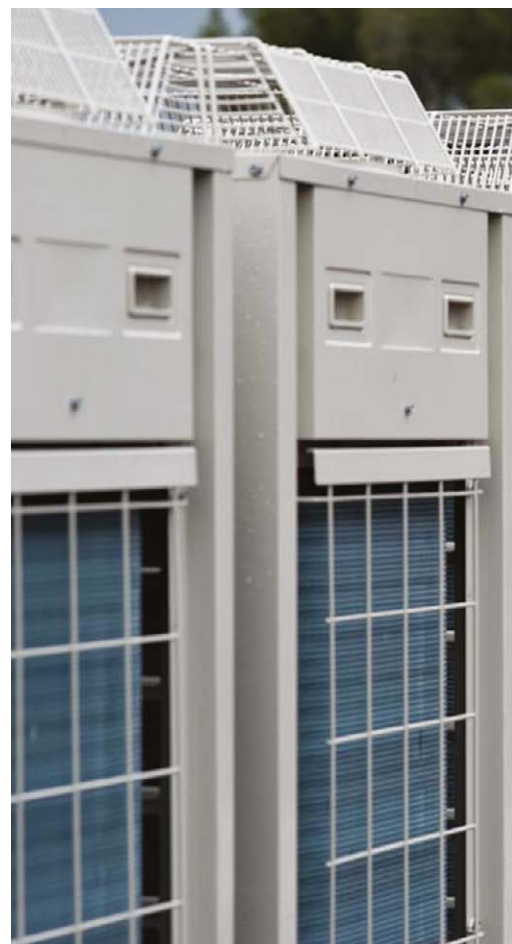
EIFFAGE ENERGIE ET EIFFAGE ENERGIE THERMIE KANCELÁŘSKÁ BUDOVA TEPELNÉ ČERPADLO VRV IV S NEPŘETRŽITÝM VYTÁPĚNÍM
